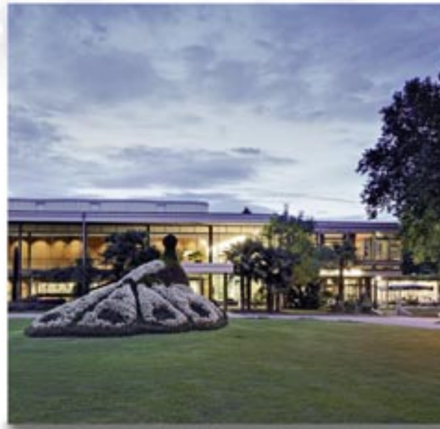
Kurhaus Bad Krozingen Kurhausstraße 1 79189 Bad Krozingen
